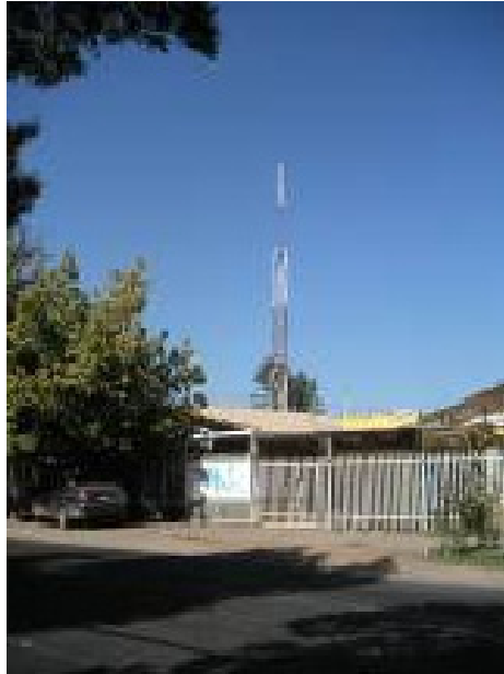
Nodo en la zona sur de Santiago, altura de la torre 15 m, antena: Trevor Marshall 16 + 16, clientes 30, enlazado con nodo en zona centro a mas de 12.
