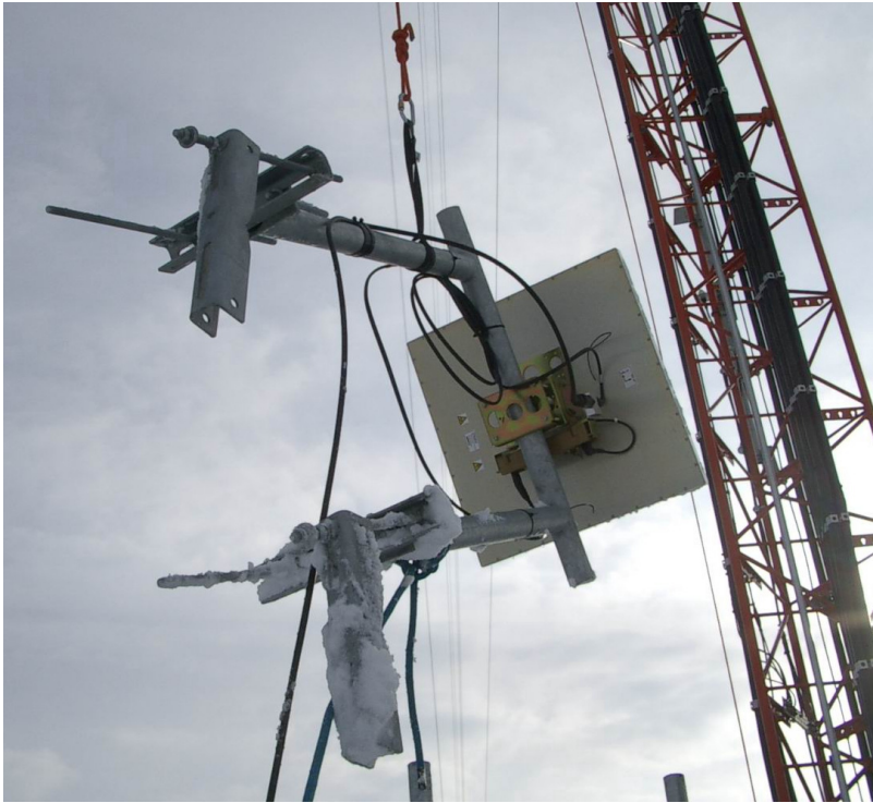
Figura 7.1: Una antena con un soporte de separación instalándose en una torre.
