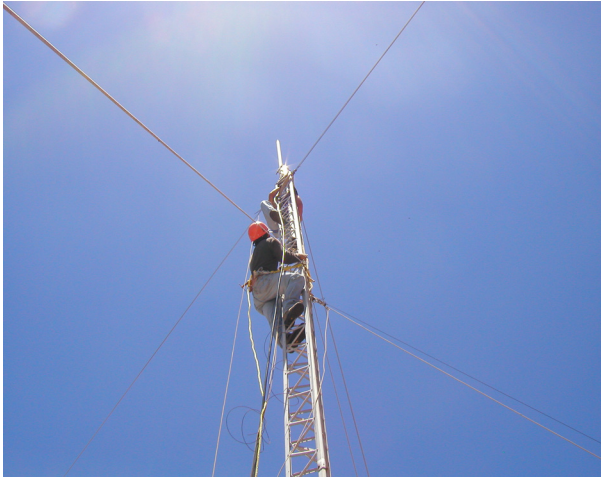
Figura 7.2: Una torre venteada escalable.
