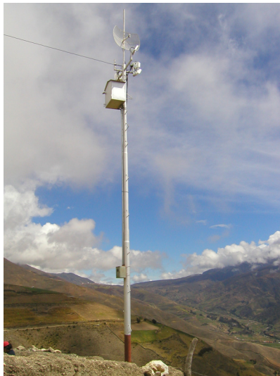
Figura 7.3: Una torre autoportada sencilla.
