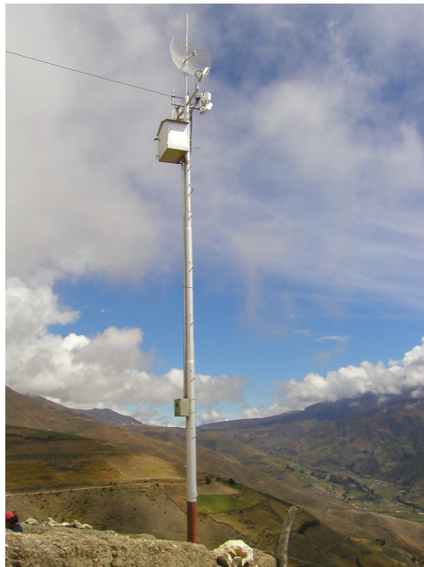
Figure 7.3: Une tour autoportante simple.
